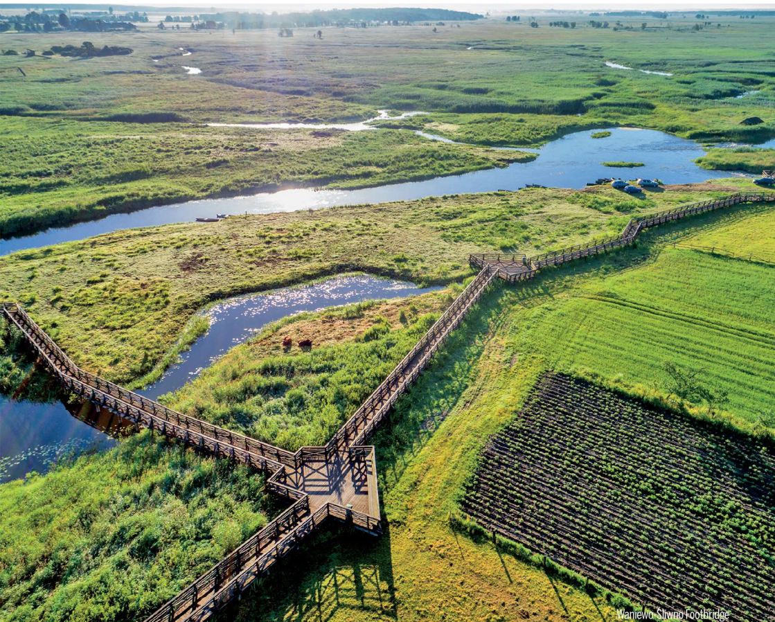
Waniewo, Słowo Footbridge
